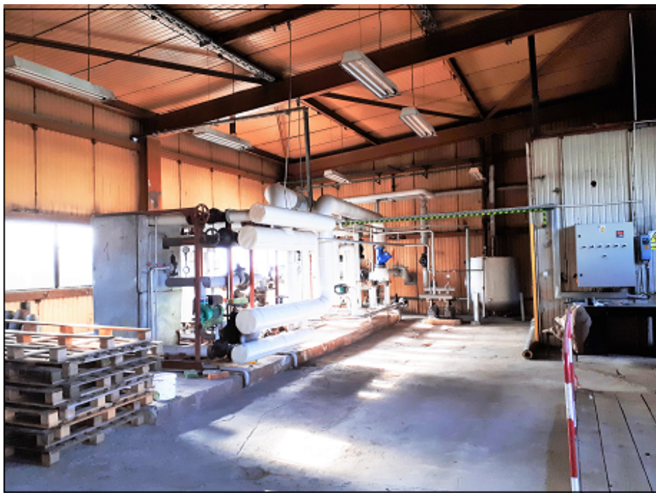
Rysunek 3. Widok pomieszczenia węzła cieplnego
