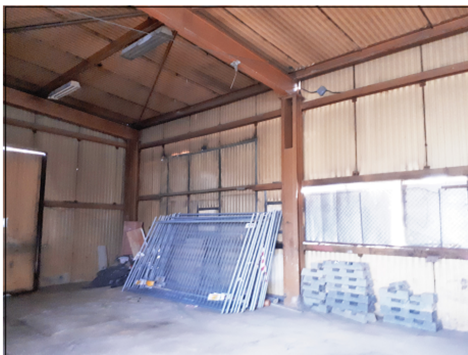
Rysunek 2. Widok od wewnątrz ściany szczytowej
